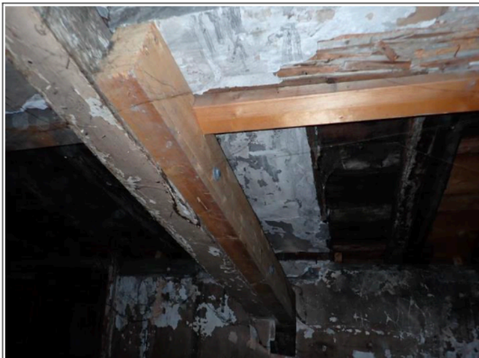
Photo 17 : combles N°7 - zone renforcée
